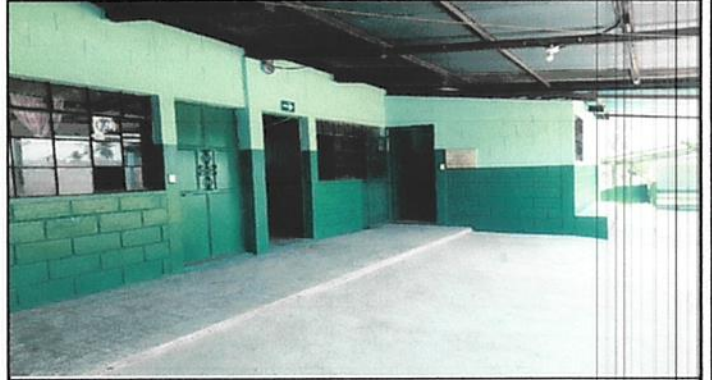
Foto 2: pintura en muros exteriores e interiores.
