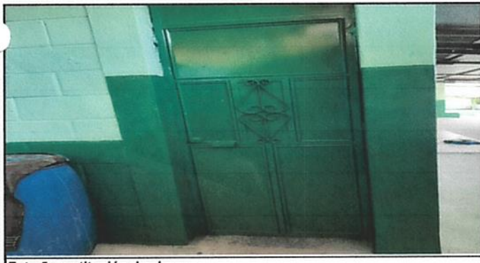
Foto 5: sustitución de chapa.
