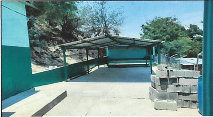
Foto 1: sustitución de lamina normal, por lamina troquelada.
