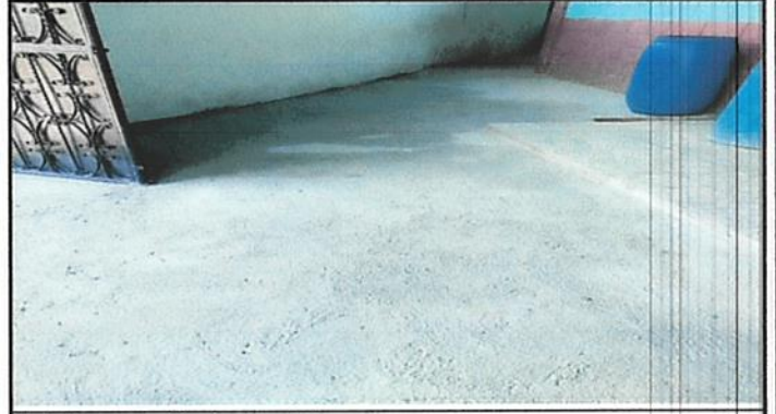
Foto 4: reparación de piso de losa de concreto.
